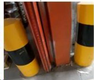
Das Tor ist in T90 Güte ausgeführt. Erkennbar am Aufbau und Kennzeichnung. Die weiteren Tore lang dieser Wand sind dauerhaft verschlossen. Die hinreichende Abschlussgüte wird aufgrund der Torblattaufbaus als gegeben erachtet. Die Gangbarmachung / Ertüchtigung der Schließlösung ist unverzüglich herzustellen.
